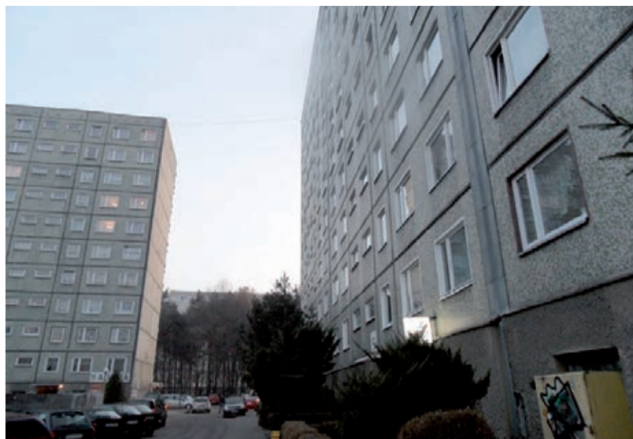
Bloki z wielkiej płyty w Giszowcu
