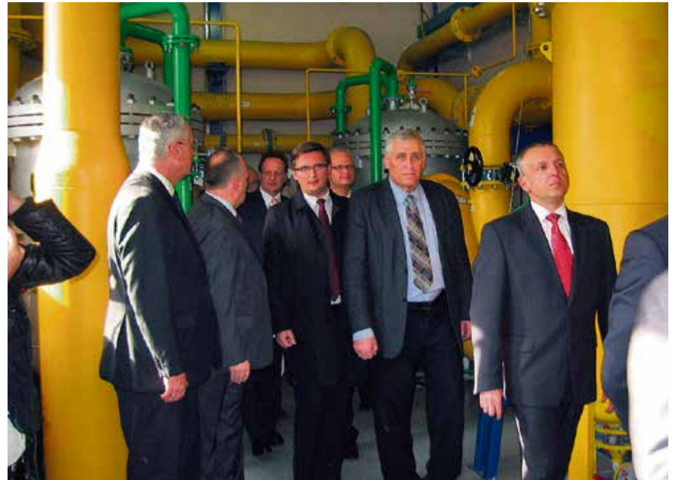
W pierwszej kolejności nowo wybudowana stacja będzie wykorzystywana do odmetanowania parceli ściany 7 w pokładzie 409 w polu panewnickim, a perspektywicznie – całego obszaru górniczego ruchu Śląsk
