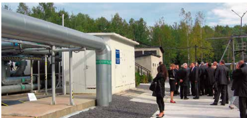
Od października ubiegłego roku wyrobiska zakładu na poziomie 1050 m są już objęte centralną klimatyzacją grupową. Przed kilkoma dniami (9 października) dyrektor kopalni Adam Zelek demonstrował gościom dopiero co uruchomioną powierzchniową stację odmetanowania
