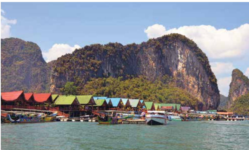
Wioskę piratów morskich wybudowano na drewnianych palach
