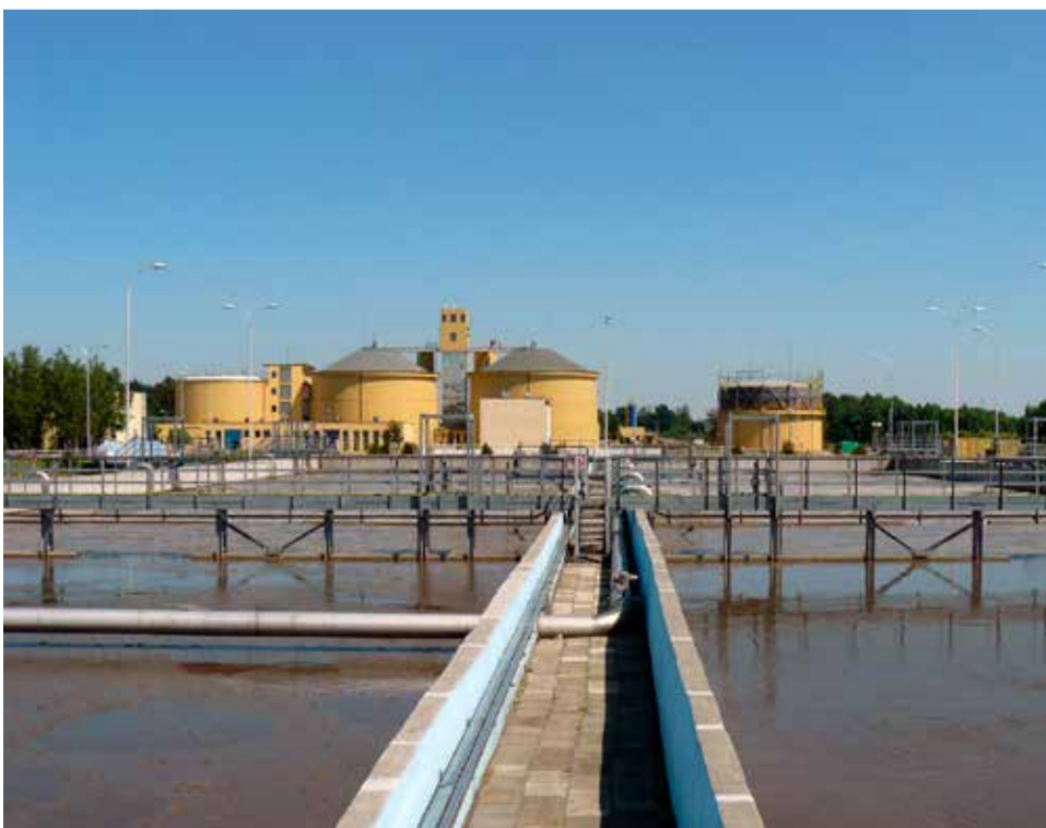
Tyska oczyszczalnia ścieków jest całkowicie samowystarczalna energetycznie, a średniomiesięczna produkcja energii odnawialnej przekracza poziom 150 proc. w stosunku do zużycia energii na potrzeby własne
