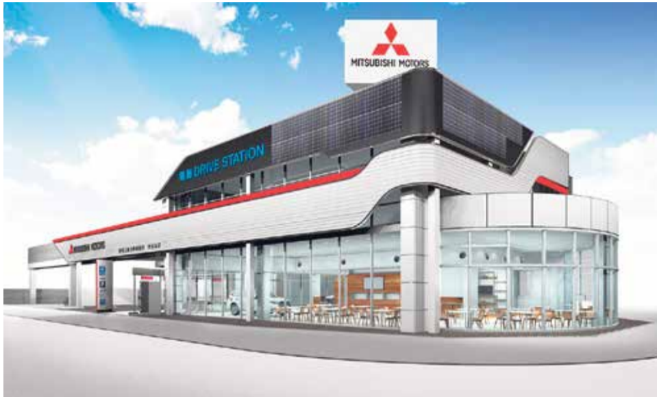
Budynek jest wyposażony w akumulatory litowo-jonowe o pojemności 12 kWh
