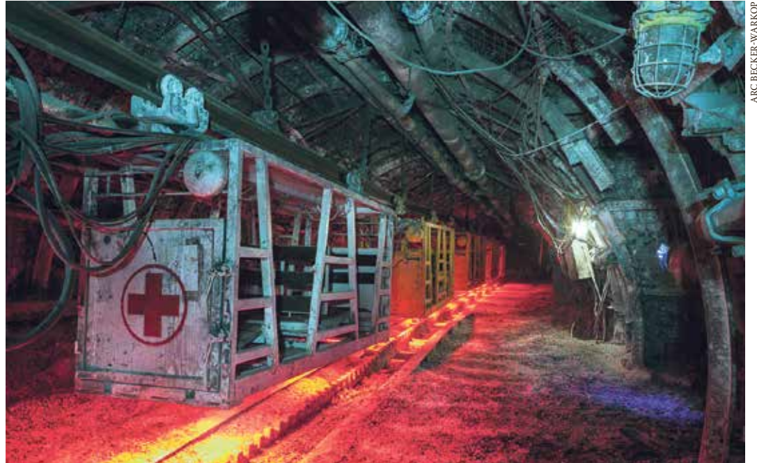
Zestawy osobowe są podświetlane od dołu na biało podczas wsiadania i wysiadania załogi do kolejki i na czerwono, gdy kolejka jest w ruchu. Podczas transportu materiału kolejka oświetla stację materiałową, ponadto może oświetlać trasę transportu
