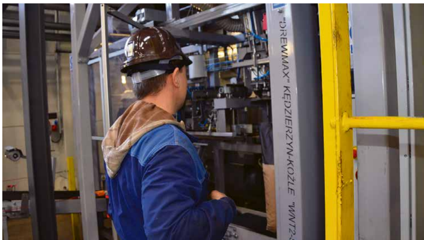
Inwestycja jest wynikiem realizacji programu badawczo-rozwojowego „Czyste powietrze dla Śląska”, którego uczestnikami są: Polski Koks SA, Jastrzębska Spółka Węglowa SA, Politechnika Śląska, Instytut Chemicznej Przeróbki Węgla oraz Stowarzyszenie Klaster Kotlarski
