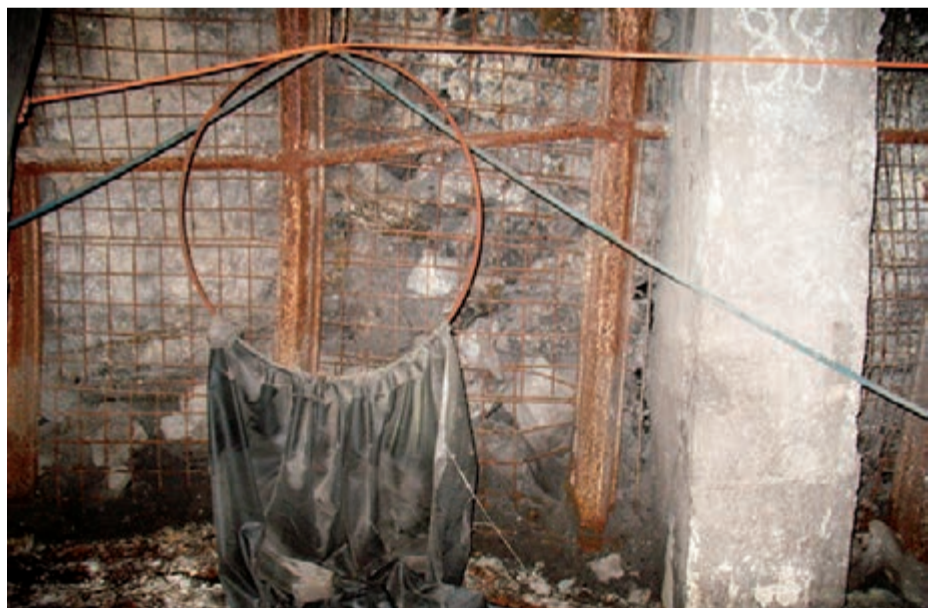
Chodnik wentylacyjny N-12, metraż 88, pierścień stalowy lutni 800 mm w miejscu oczekiwania poszkodowanych na pomoc
