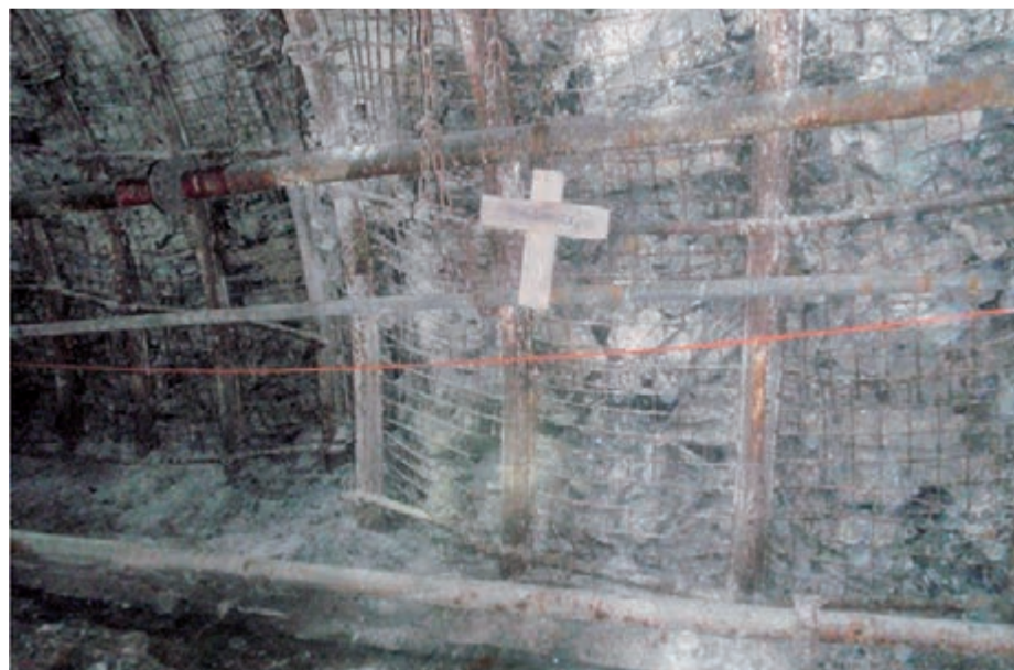
Chodnik wentylacyjny N-12, metraż 222, krzyż drewniany w miejscu znalezienia ciała jednego z ratowników
