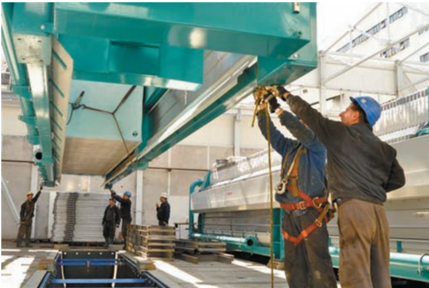
Trwa montaż nowoczesnej prasy
